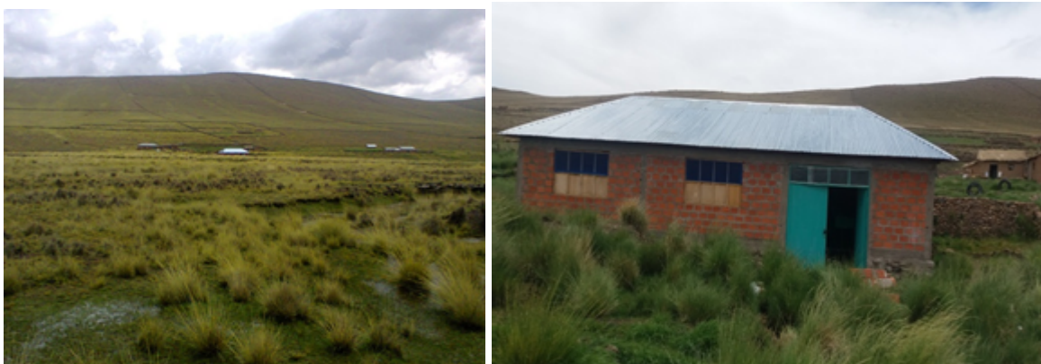
Figura 03: Entorno natural e infraestructura externa del laboratorio de recría de alevines
